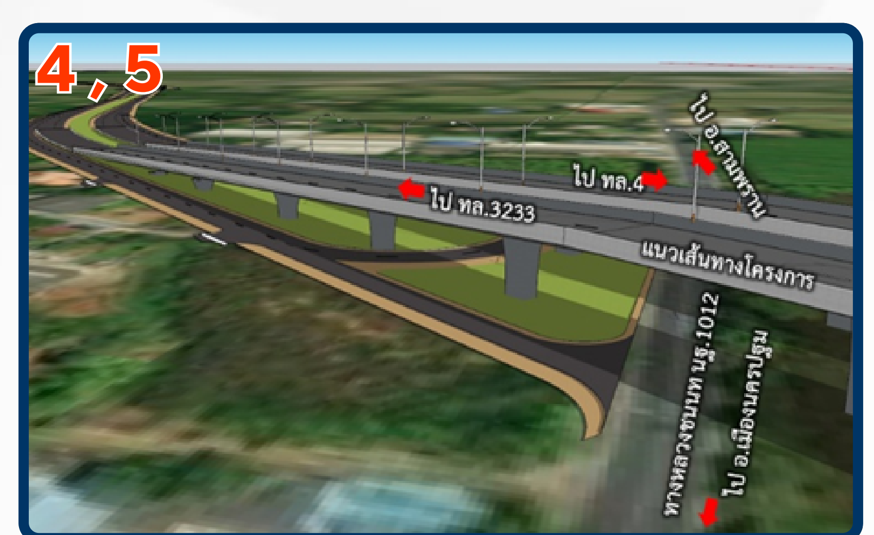
ทางยกระดับข้ามถนนทางหลวงชนบท สาย บข.1012 และจุดกลับรถใต้สะพาน
